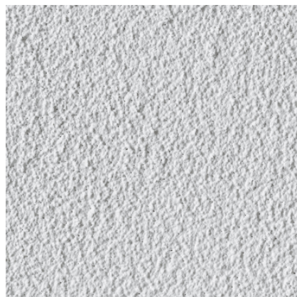
Paredes exteriores revestidas a sistema capoto com acabamento areado
