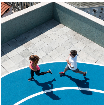
Pista de corrida em betão decorativo, com 80mm de espessura
