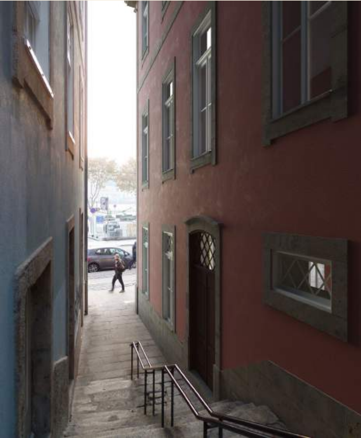
Alçado lateral do Alfândega 80 visto das Escadas do Caminho Novo Alfândega 80's lateral facade's view over Caminho Novo's stairs
