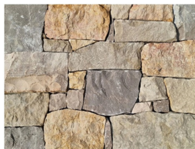
Muros vedação exterior em pedra natural
