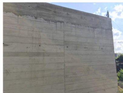
Varandas em betão aparente
