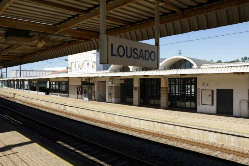
ESTAÇÃO DE COMBOIOS LOUSADO
