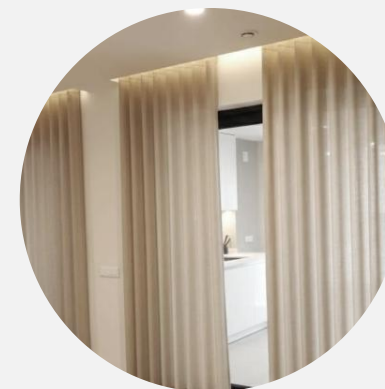
Sistema de iluminação de sanca
