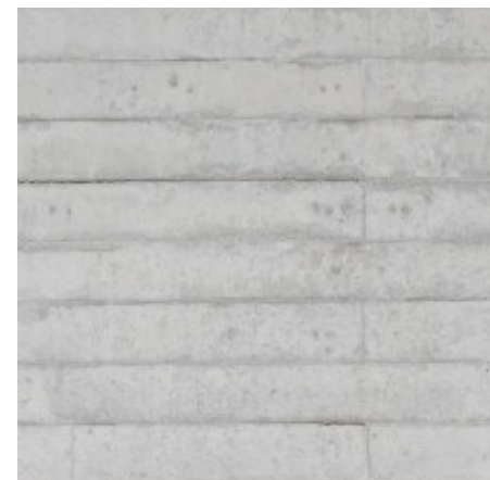
Betão aparente com cofragem em réguas de madeira aplicadas na horizontal
